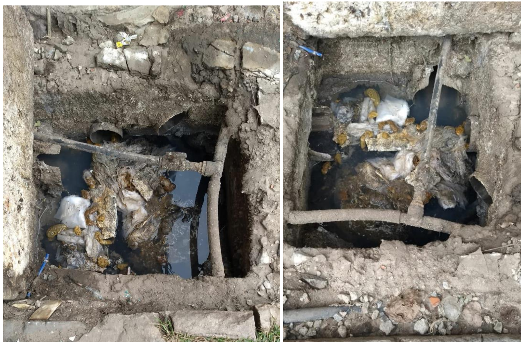
Mangueras para transporte del agua de consumo en el interior de cámaras cloacales
