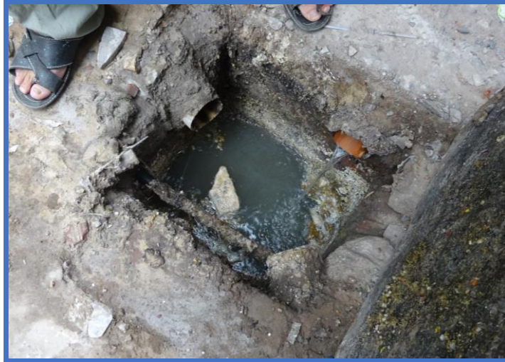
Figura1.- Manguera de agua pinchada atravesando una precaria cámara cloacal (Ciudad Oculta Mz 32)
