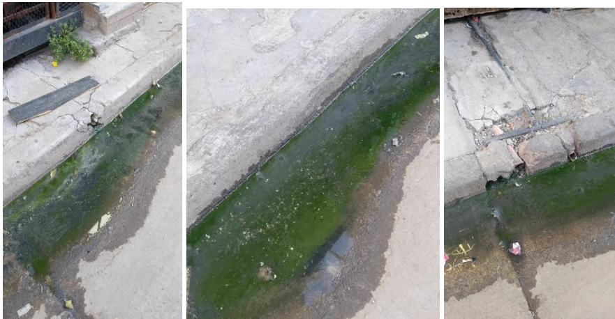
Imágenes de aguas residuales con contenido cloacal escurriendo por el cordón cuneta de la vía pública Rodolfo Scapino
