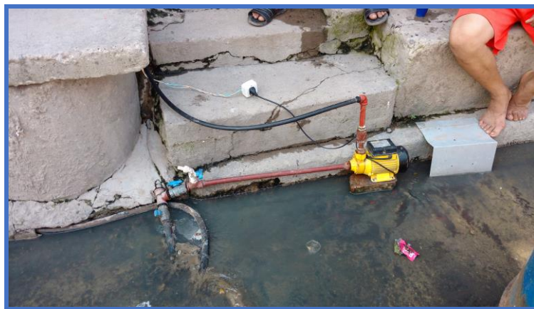
Figura 2.- Manguera de agua pinchada utilizada para abastecer a 25 familias conectada a un motor e inmersa en líquido cloacal en Santo Domingo y calle s/n (La Loma-Villa 21-24)
