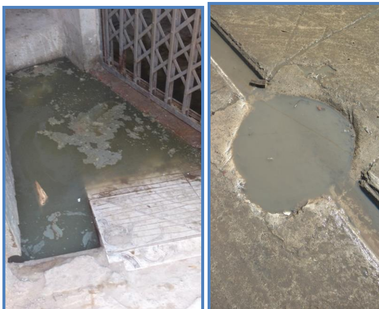
Figura 6.- Izquierda intersección de Ana María Janer y Mz 6 (Barrio Los Piletones), se observa sobre la calzada la presencia de líquido marrón sin escurrimiento en la canaleta pluvial. Derecha Manzana 10 Casa 76 (Barrio Los Piletones), se observa la presencia de líquido cloacal en el ingreso a la vivienda.
